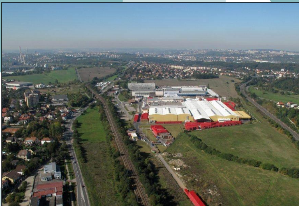
pohled na areál Coca-Cola HBC Česká republika od východu, (AS CHEMOPRAG, říjen 2011)
