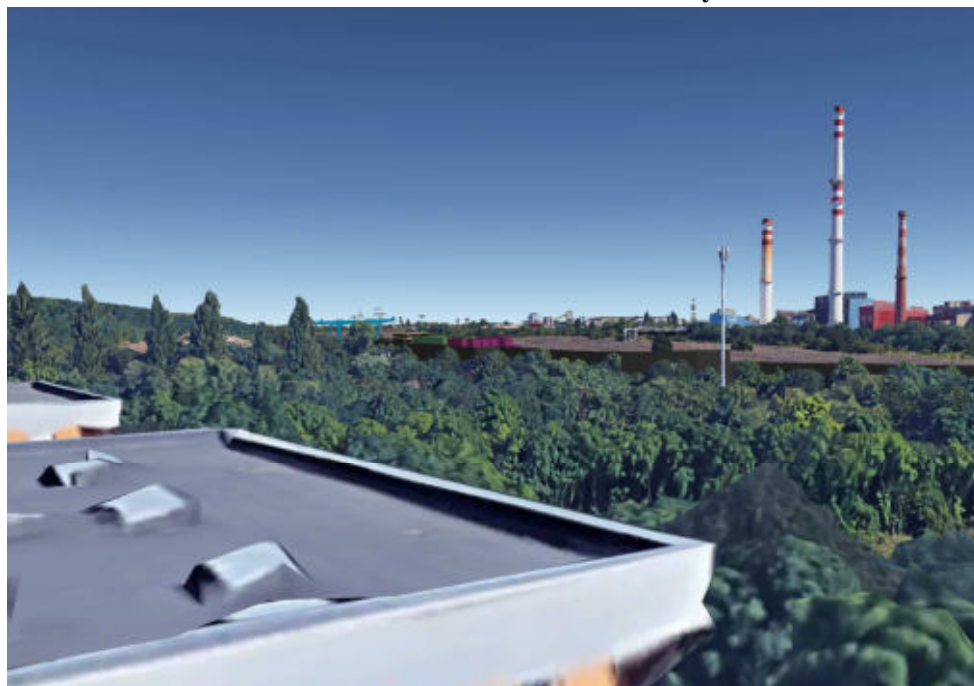
Obr.č.17 Pohled směrem na posuzovaný záměr z posledního patra bytového domu v Ungarově ulici.
