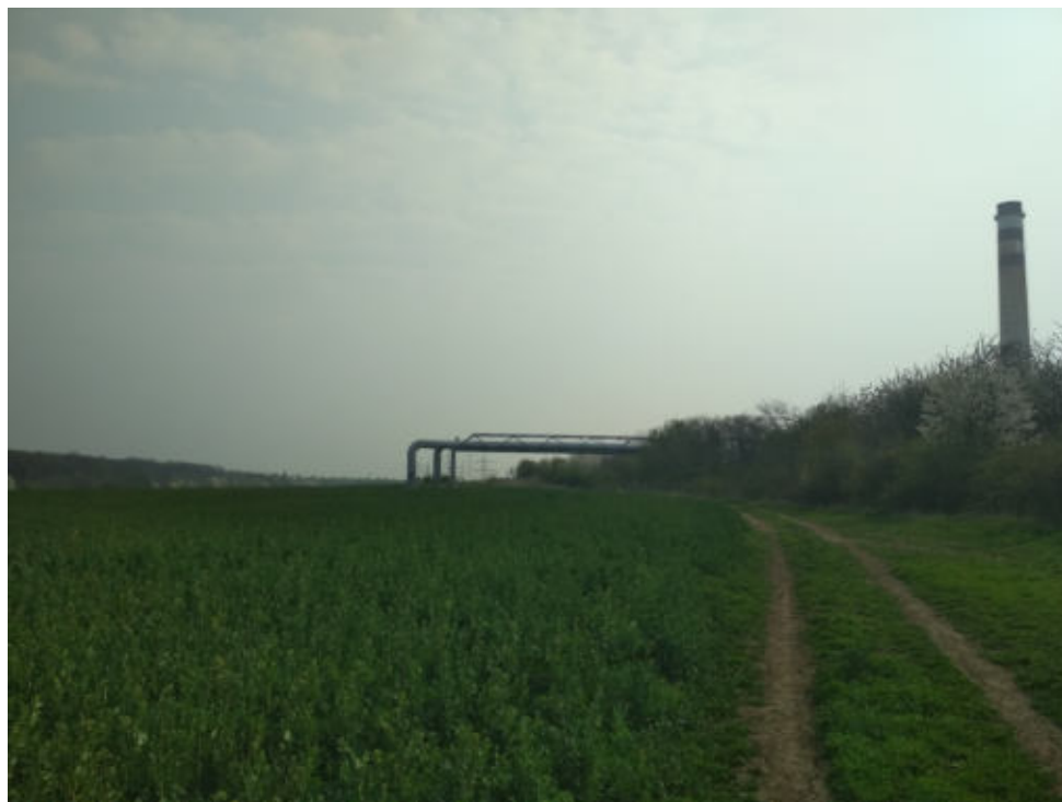
Obr.č.16 Pohled z budoucího terminálu směrem k ulici Průmyslová.
