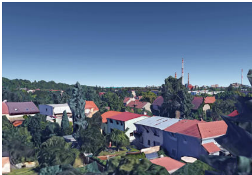
Obr.č.18 Pohled směrem na posuzovaný záměr z Malešického parku.
