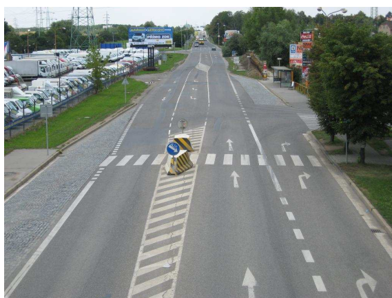
Obr. 40 – celkový pohled na přechod
