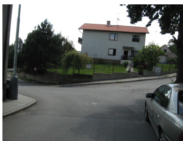
Obr. 74 – pohled na ÚK z Tálinské
