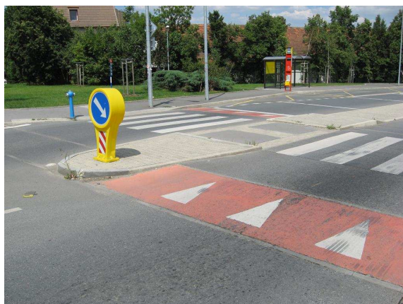
Obr. 7 – zvýraznění najížděcí rampy (pohled směrem na Černý most)
