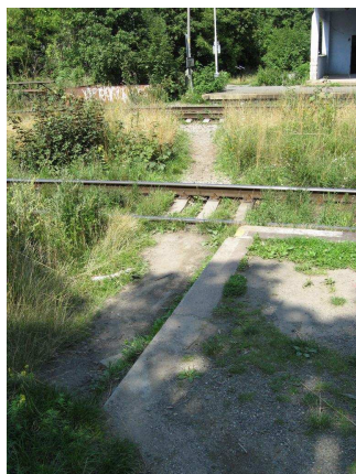
Obr. 20 - vyšlapaná cestička v kolejišti
