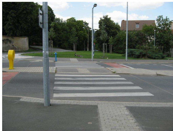
Obr. 6 – detail zvýšené části prahu a hmatných prvků
