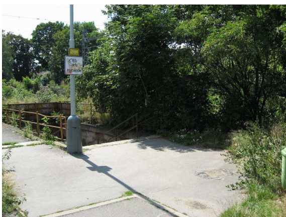
Obr. 16 - vchod do podchodu ze Šimanovské ulice
