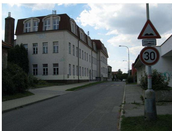
Obr. 88 – pohled na budovu školy (směr k železniční trati)
