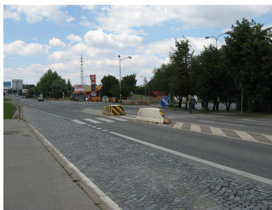
Obr. 41 – pohled na přechod ze zastávky MHD směrem od centra Prahy – IP 6 ve větvích stromů
