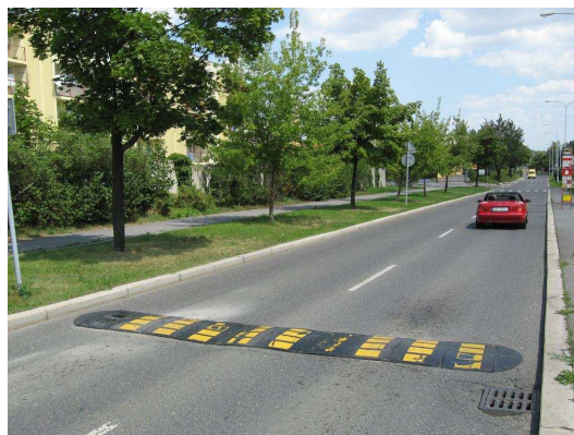
Obr. 60 – detail úzkého příčného prahu
