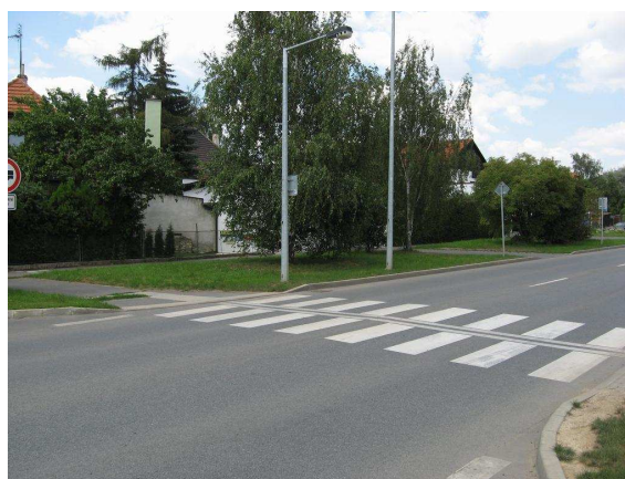
Obr. 78 – přechod u zastávky v blízkosti ÚK Broumarská x Horusická
