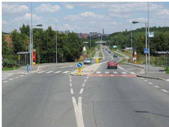
Obr. 5 – celkový pohled (pohled směrem na Černý most)
