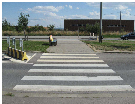
Obr. 86 – Ocelkova ulice, detail přechodu pro chodce
