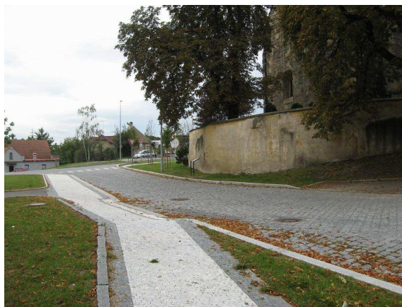
Obr. 33 – místo pro přecházení ulice Šimanovská
