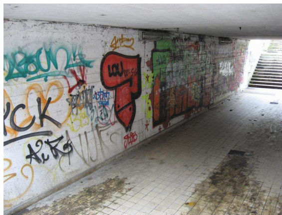
Obr. 19 - stav stěn a podlahy
