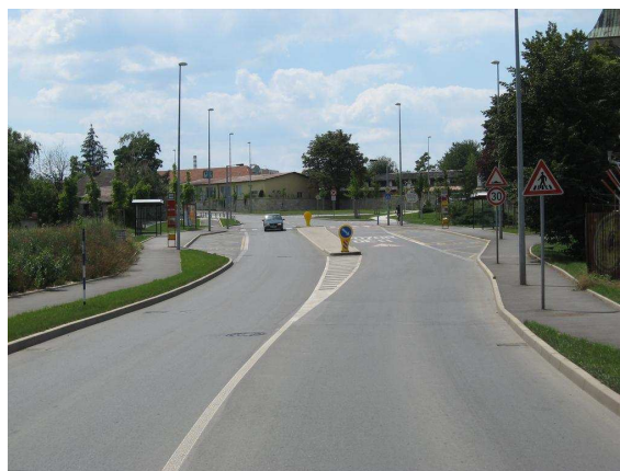
Obr. 8 – celkový pohled (pohled směrem od Černého mostu)
