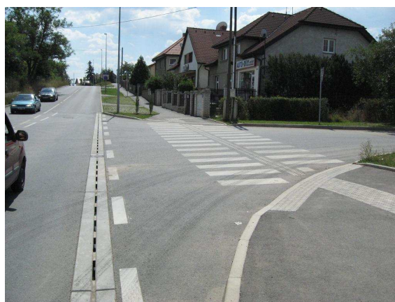
Obr. 38 – přechod v pohledu od nadjezdu železniční trati
