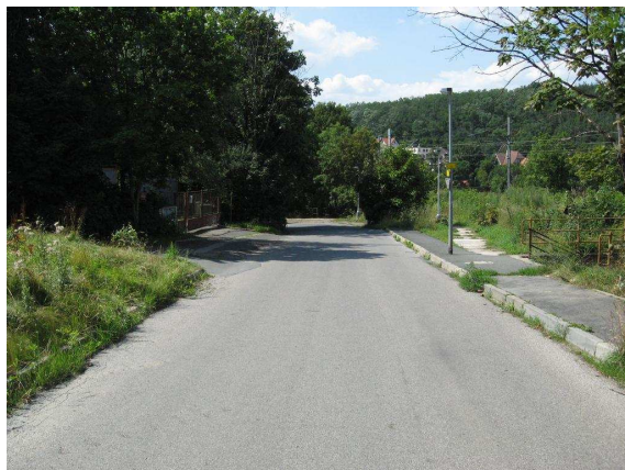
Obr. 45 – pohled na místo ve směru od ulice Broumarská
