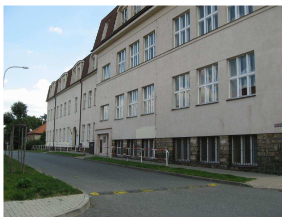
Obr. 89 – pohled na budovu školy od křižovatky Šimanovská x Za Školou
