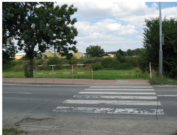
Obr. 26 – první přechod ve směru od Dolních Počernic
